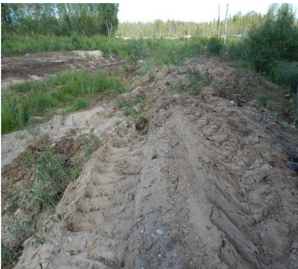
Kuva 1: ojat, altaat on kaivettu mineraalimaahan
